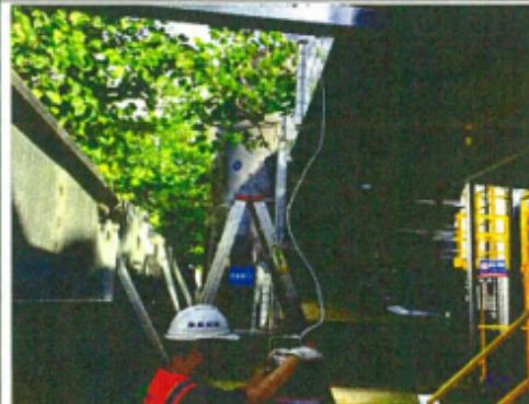
硫化车间废气 DA045 处理前监测口
