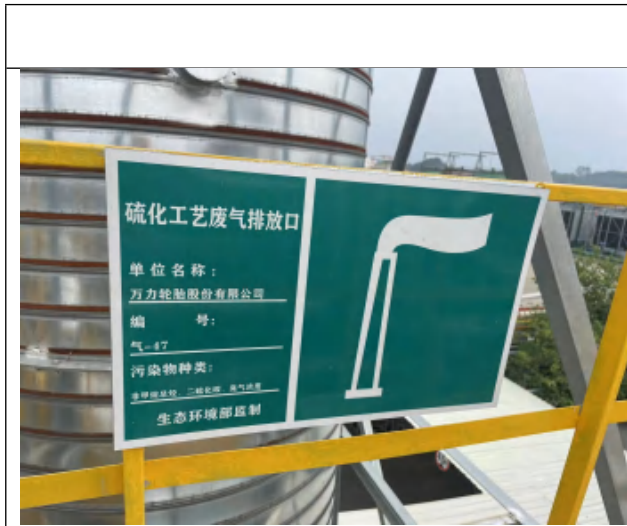
图 4.2-8 新增气-47 胶冷废气排放口近照
