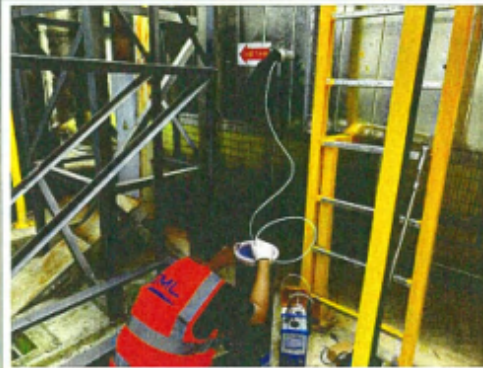
硫化车间废气 DA044 处理前监测口
