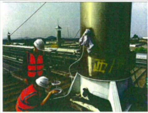
硫化车间废气(气-02)处理前监测口
